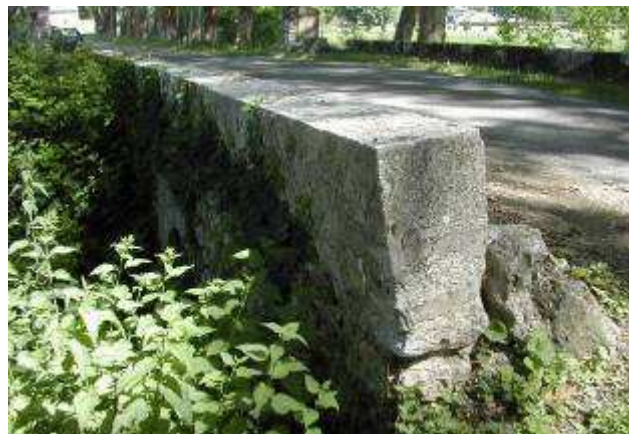
Si le parapet gauche ne devrait avoir besoin que de quelques pierres supplémentaires, la situation du parapet droit est plus inquiétante. Une étude plus approfondie d'organismes compétents devrait nous informer sur la gravité et l'urgence de la situation
