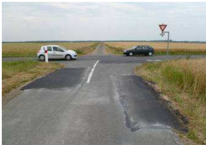
Chemin des Renuelles à Villeneuve : carrefour avec la D 140
