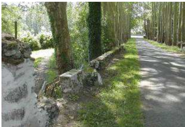
Si le parapet gauche ne devrait avoir besoin que de quelques pierres supplémentaires, la situation du parapet droit est plus inquiétante. Une étude plus approfondie d'organismes compétents devrait nous informer sur la gravité et l'urgence de la situation
