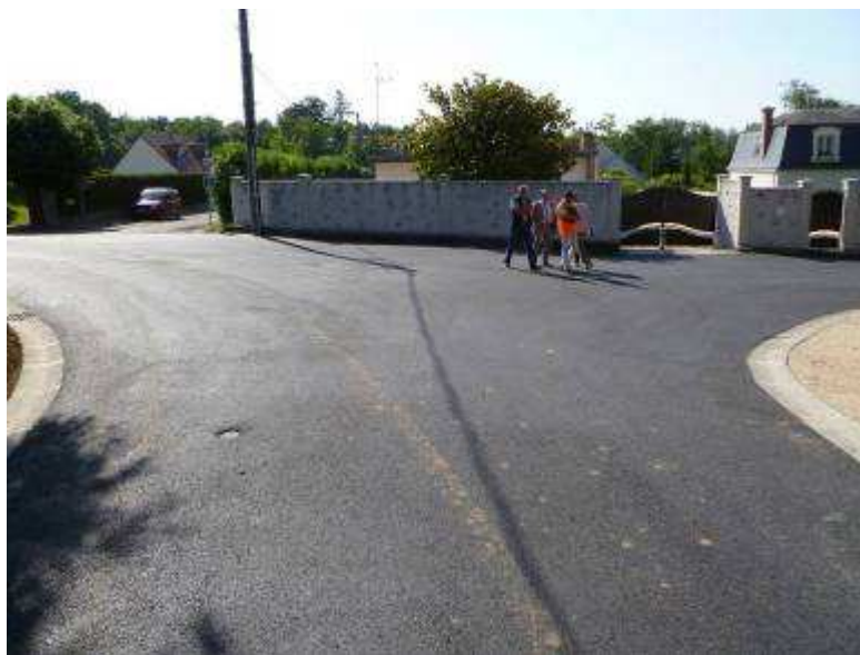
Visite de fin de chantier sur le nouveau « carrefour Médicis »
