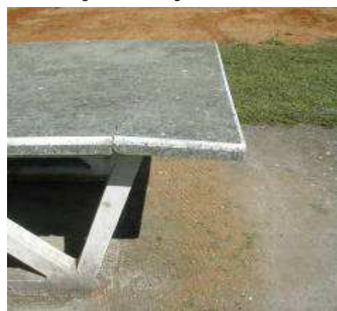
Si le parapet gauche ne devrait avoir besoin que de quelques pierres supplémentaires, la situation du parapet droit est plus inquiétante. Une étude plus approfondie d'organismes compétents devrait nous informer sur la gravité et l'urgence de la situation
