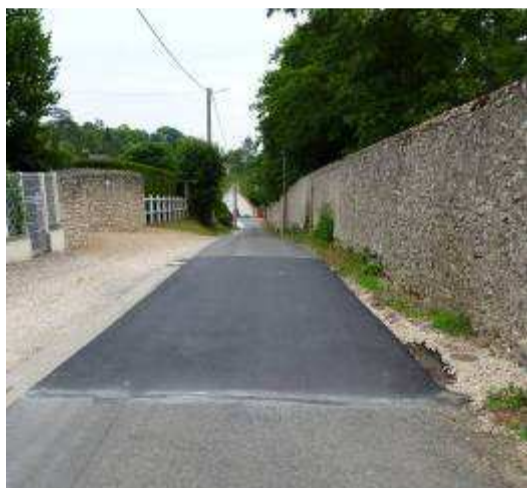
Rue de la Borde à Macé
